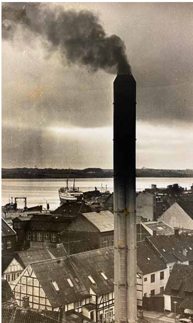
Faaborg El-Værk fik ny skorsten i 1968, og der blev taget et billede fra toppen mod den gamle skorsten og havnen
