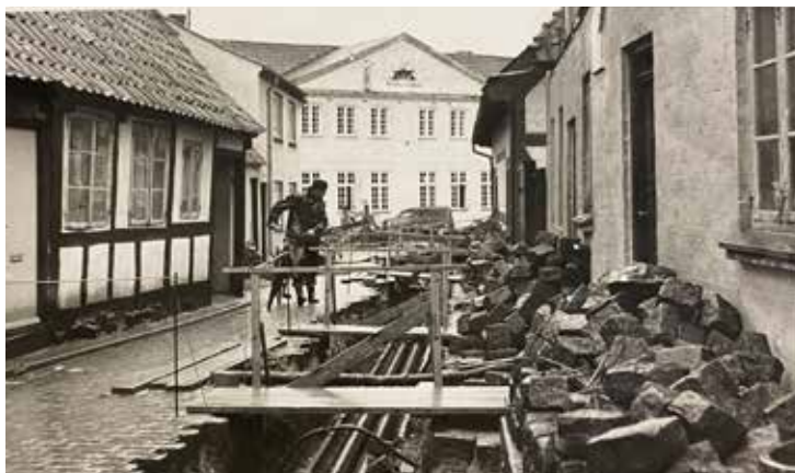
En cyklist ser nysgerrigt til under nedlægningen af fjernvarmerør i Grønnegade i 1953
