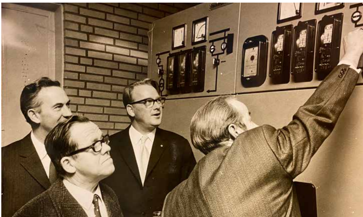
Elværkets leder Max Hansen sammen med Alf Toftager og to ukendte personer tænder for strømmen på transformatorstationen på Vængegyden i 1970. Det fejres behørigt med portvin i glasset
