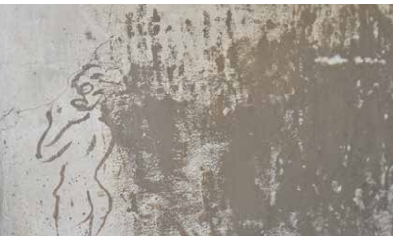
På den ene væg i keramikværkstedet fandt parret en af Peter Sekjærs tegninger, en veldrejet dame naturligvis. De besluttede derfor at flytte varmepumpen, så historien i huset får lov at leve videre
