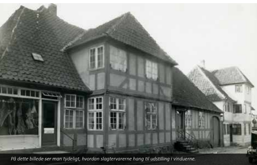
Hobys Gaard i Holkegade er også en del af bygningsmassen, som foreningen har overtaget.
