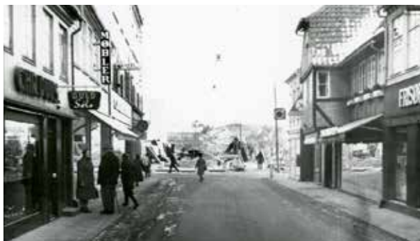
Mellemgades forlængelse- 1964- Gl. bygninger der nedrives til fordel for Administrationsbygning til Faaborg Kommune- Bygning nedrives for at give plads til Lægehuset
