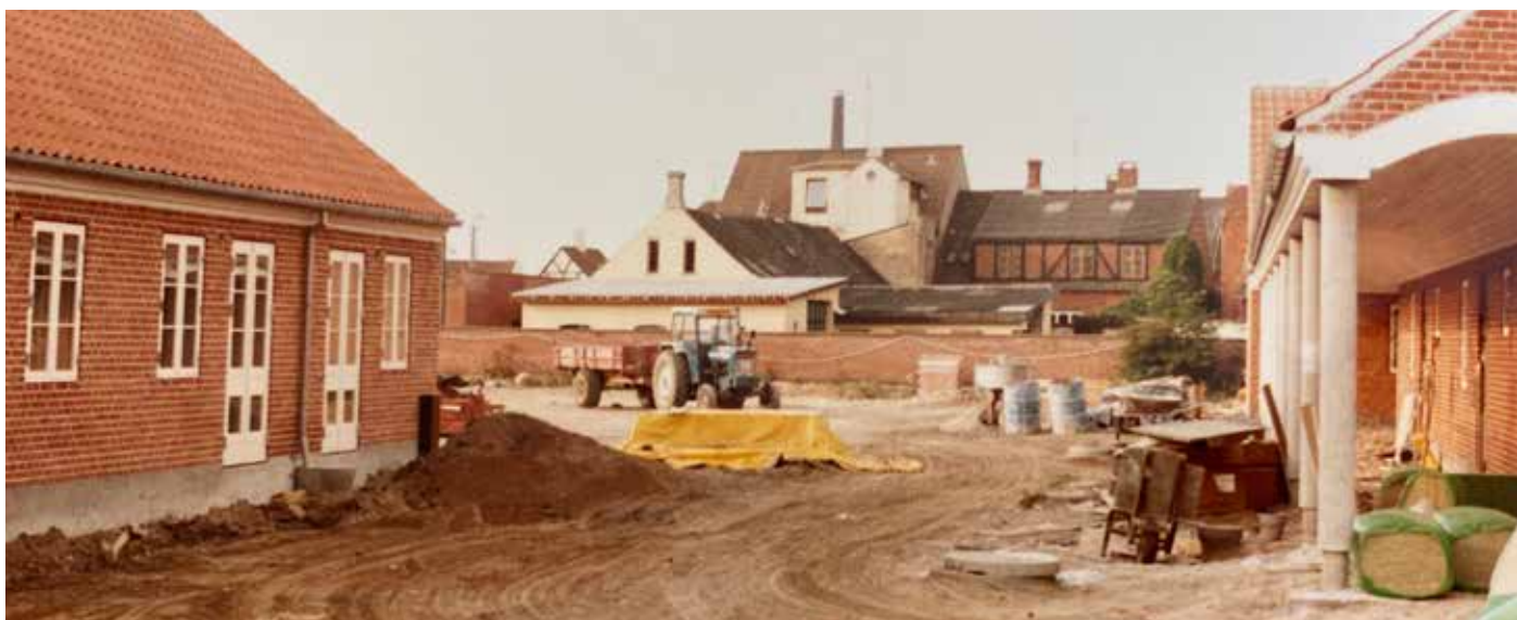
Etableringen af Tømmergården i Faaborg i 1984
