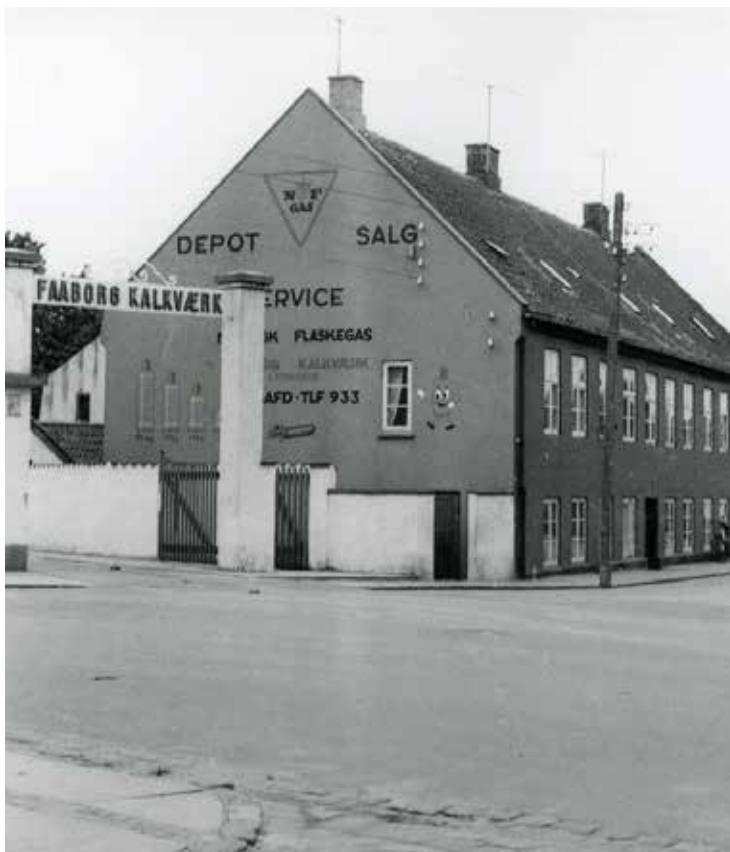
Lagonis Minde 6 kaldet "Støberhusene", der blev nedrevet 1966
