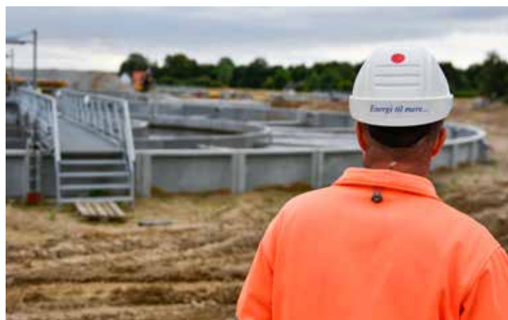
Anlægsarbejdet startede i april 2019 og står helt færdigt i oktober 2020. Betonet fra de gamle trippelkanaler er blevet knust og brugt som bundopbygning i de nye adgangsveje på pladsen. Genbrug og miljøvenlighed er nemlig et af fokusområderne for FFV, når de bygger
