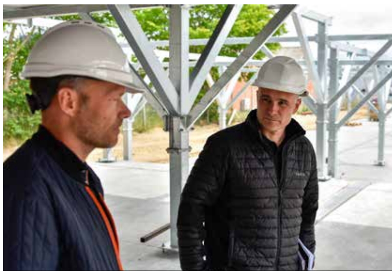
Mark Lange (t.h.) fra Verdo Energy Systems er manden, der skal sikre, at alle rør-føringer på det enorme anlæg ender med at være placeret og forbundet korrekt
