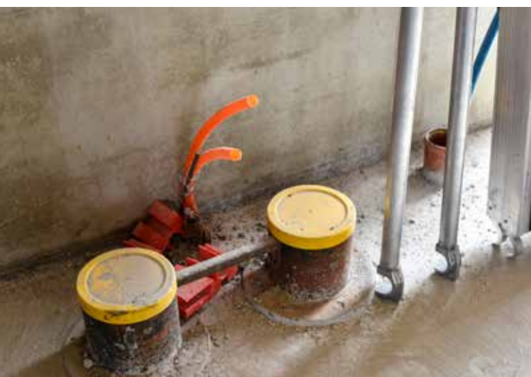
Dette er hovedrolleindehaverne i hele projektet. Nemlig de to rør der fører alt det varme fjernvarmevand ud til kunderne
