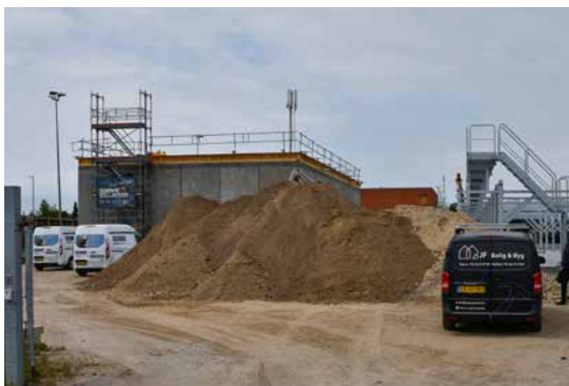
På byggepladsen arbejder de mange håndværkere hårdt på at kunne have det hele færdigt, så forbrugerne allerede til december kan få klimavenlig og billig varme fra det nye anlæg
