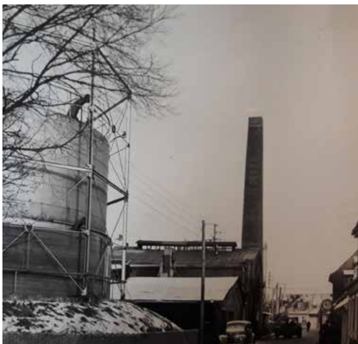
Gasværket før det blev revet ned i 1962 - Det nuværende Færgevej
