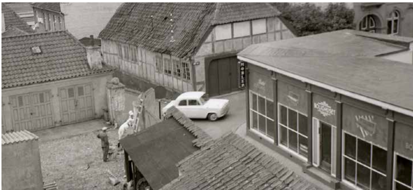
Jomfrulågen, nedrivning af gammel skolebygning, 1963, foto RJ
