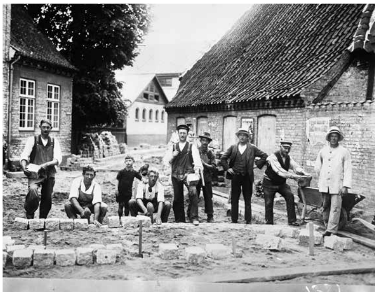
Brolæggere i Grønnegade, 1926, foto Johannes Rasmussen
