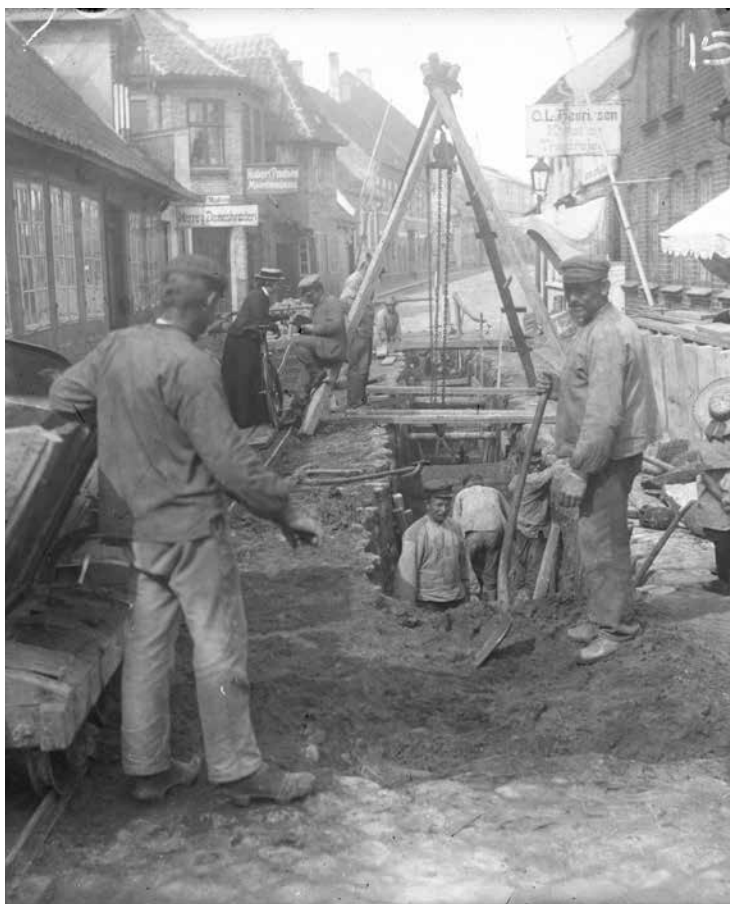
Vestergade, ca. 1908, hovedkloakledning nedlægges
