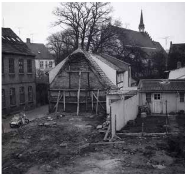
Brandtomten i Grønnegade-Hospitalsstræde efter branden, 1971
