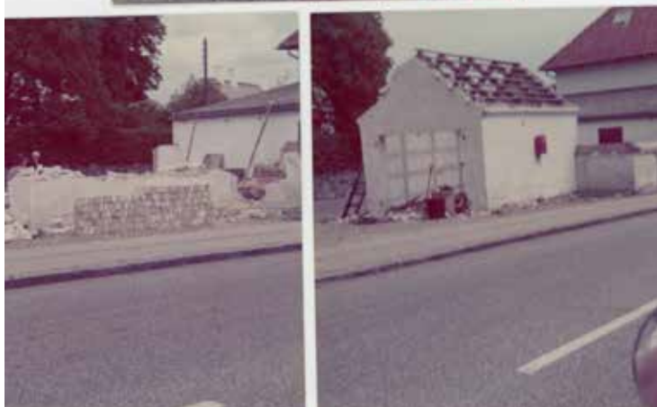
Nedrivning af garagen "det tidligere sprøjtehus", Svendborgvej 419, 1975
